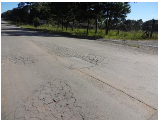
Km 12 - Situação do pavimento
