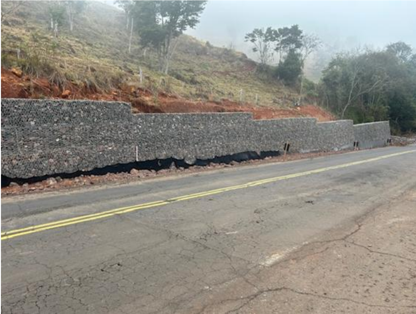
26 - Contenção executada no km 61,00
