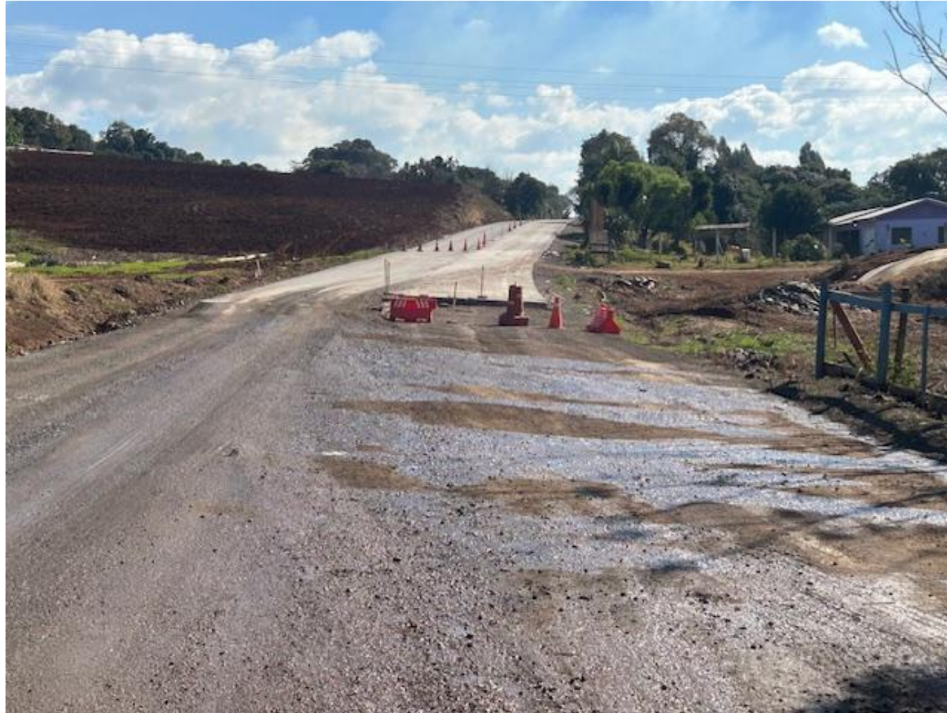
12 – Início do pavimento em concreto no sentido Campo Erê
