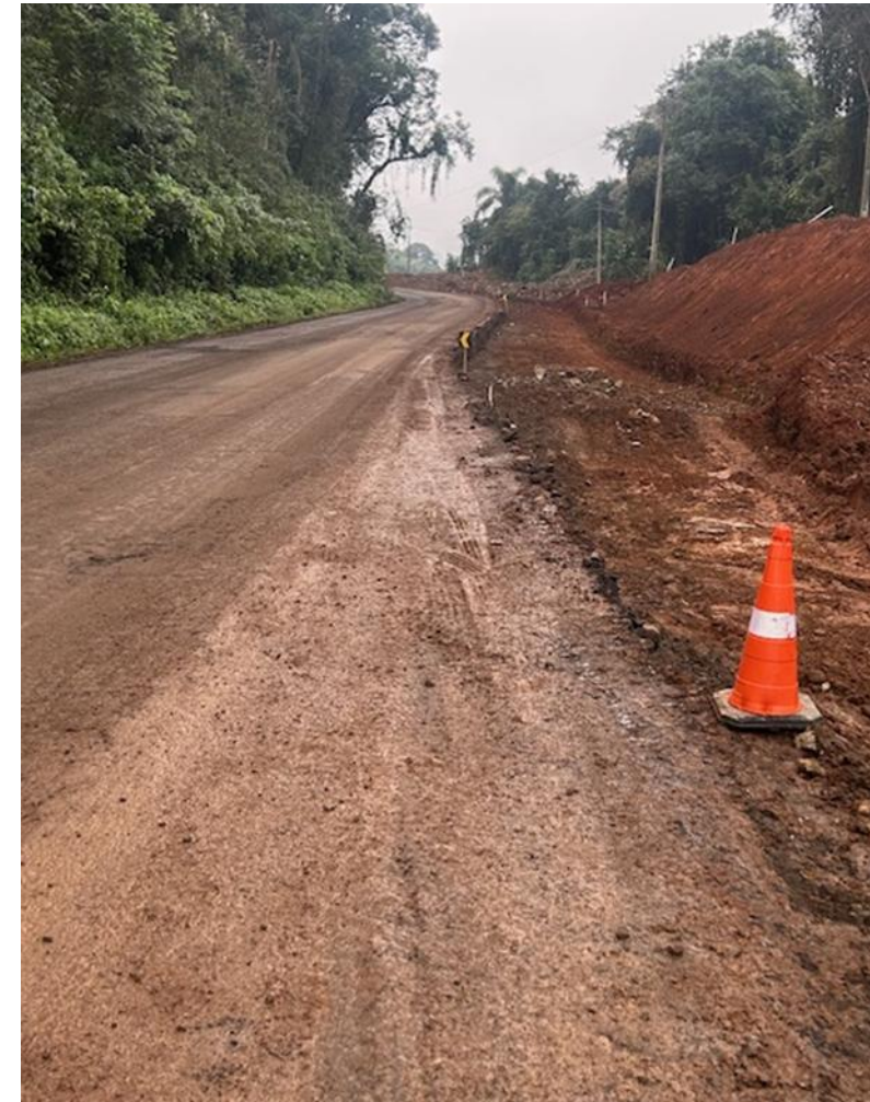
23 – Alargamento da pista no km 75,00 (obras em andamento)
