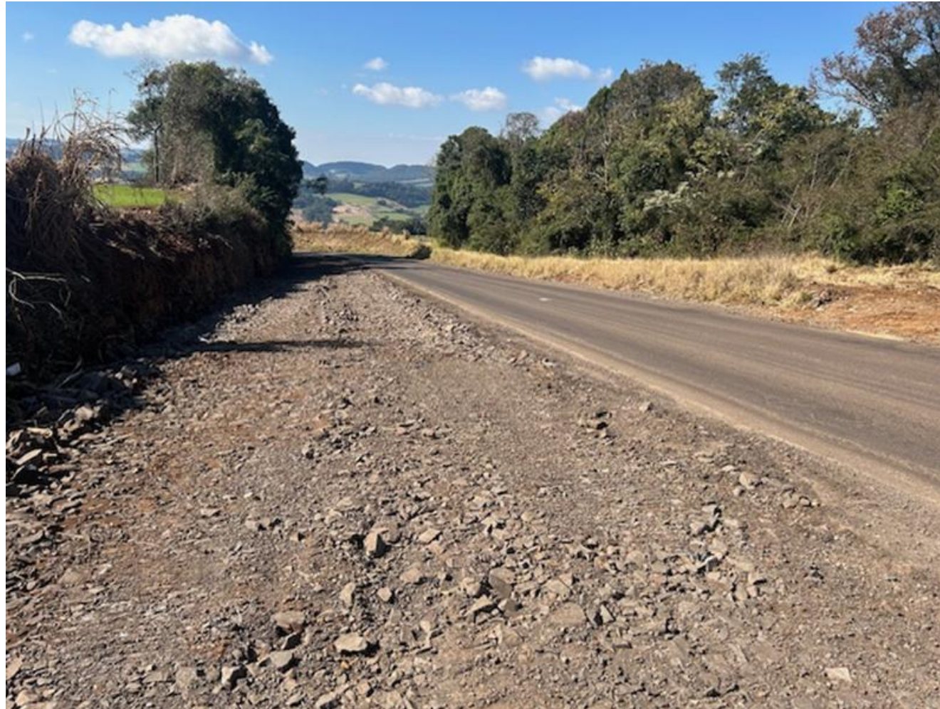
5 – Base em execução da 3ª faixa – km 8,20
