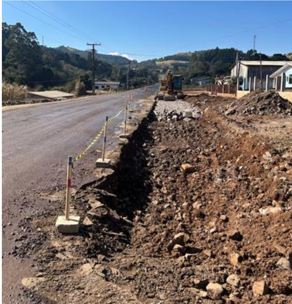
9 – Base em execução da 3ª faixa – Três Voltas (km-15,20)
