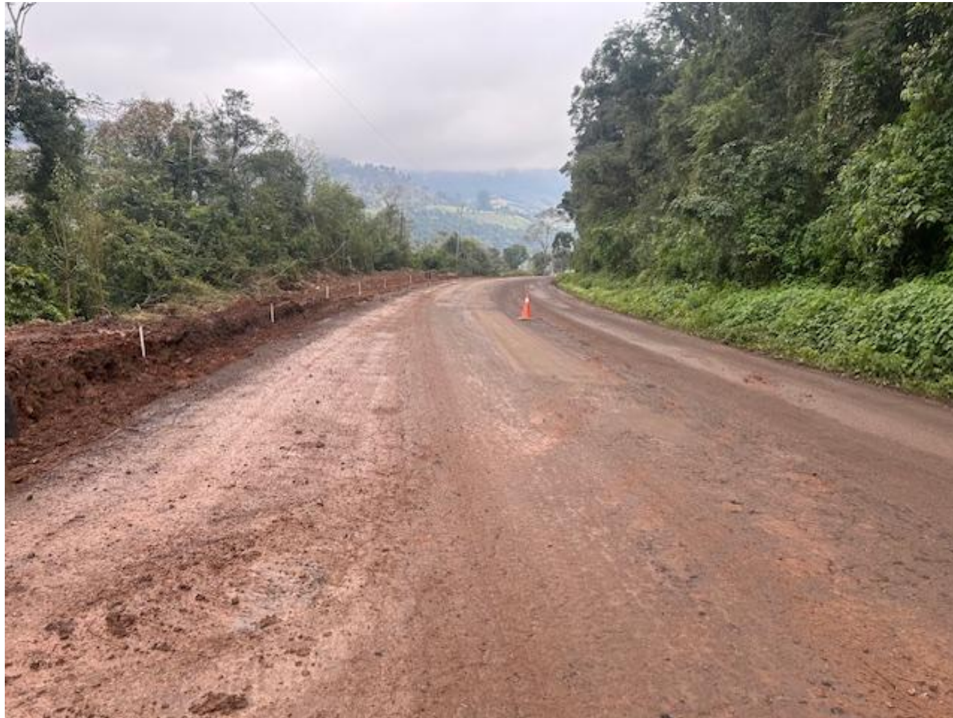
24 – Outra vista das obras de alargamento para 3ª faixa, em andamento
