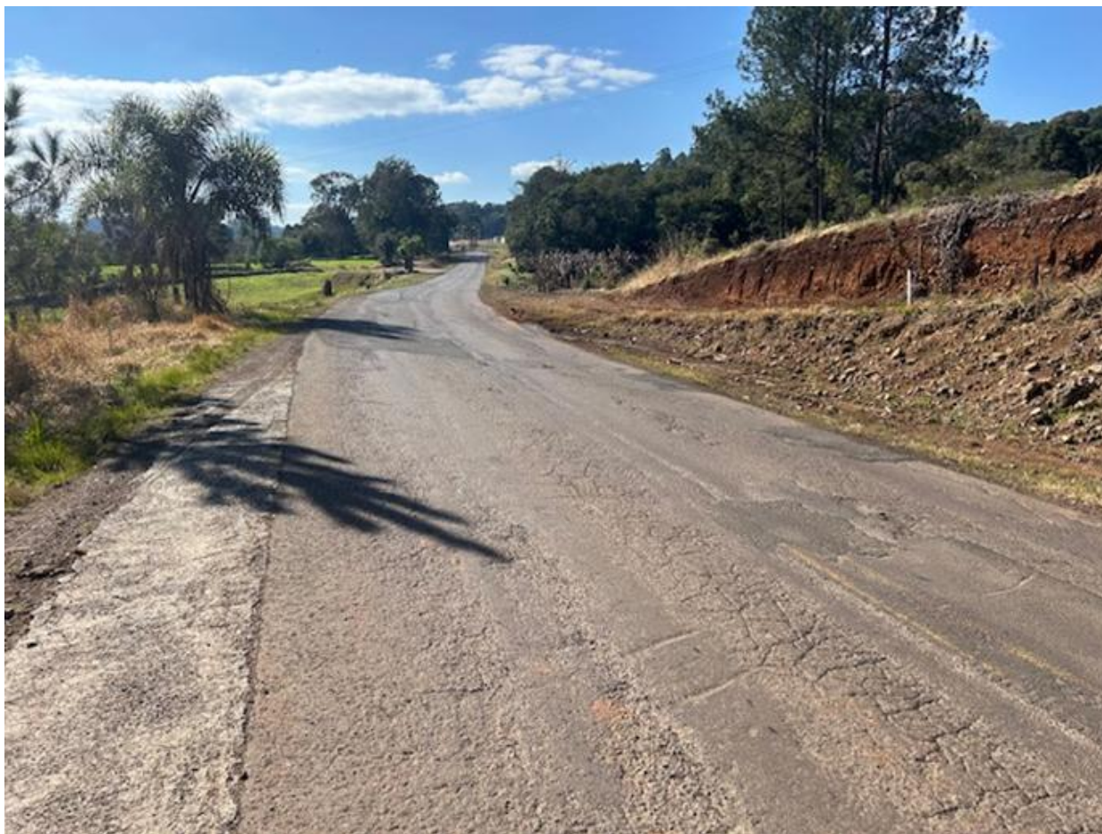
2 – Desagregação do pavimento – km 2,80
