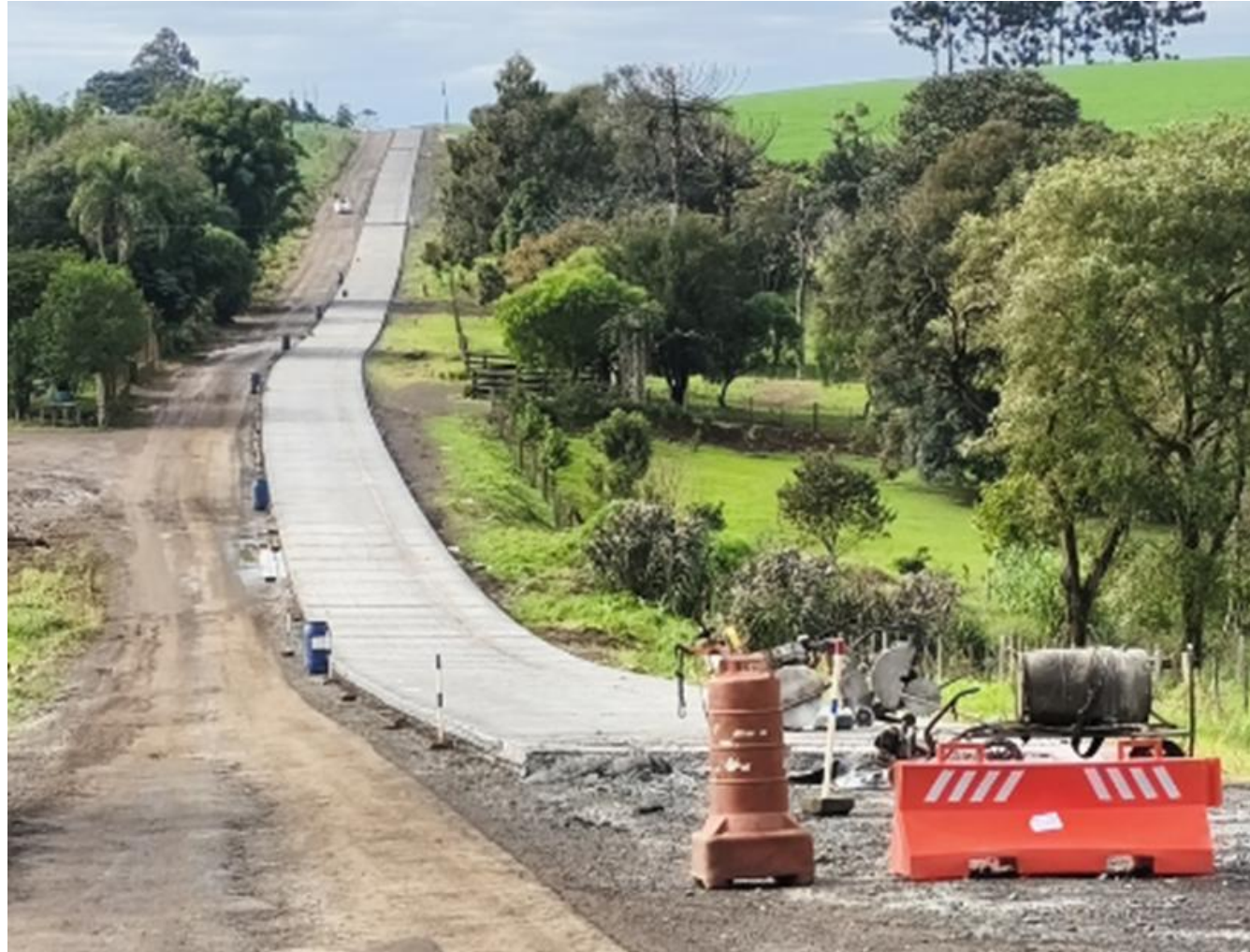
13 – Meia pista com pavimento concretado. (Foto Divulgação)
