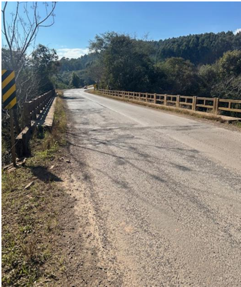
3 – Situação da ponte existente no km 6,20
