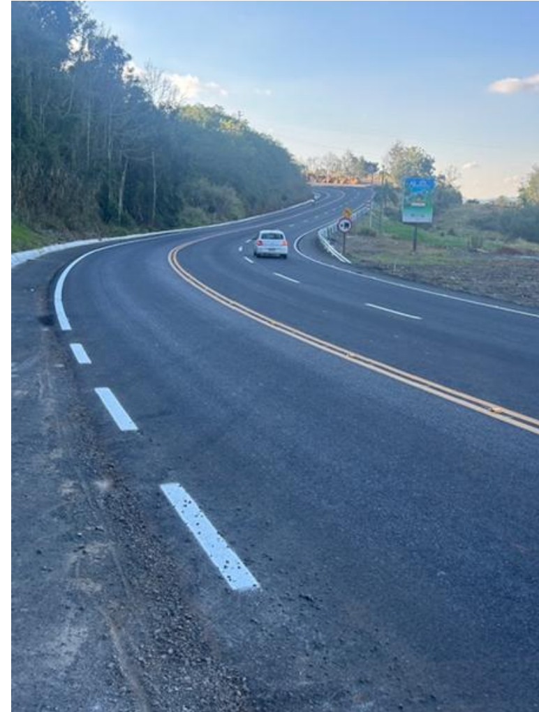
20 – Subtrecho Palmitos/São Carlos – Pavimento já restaurado
