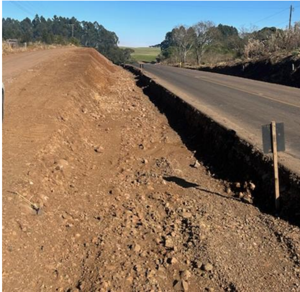
22 - Obras no km 70,00 (em andamento)
