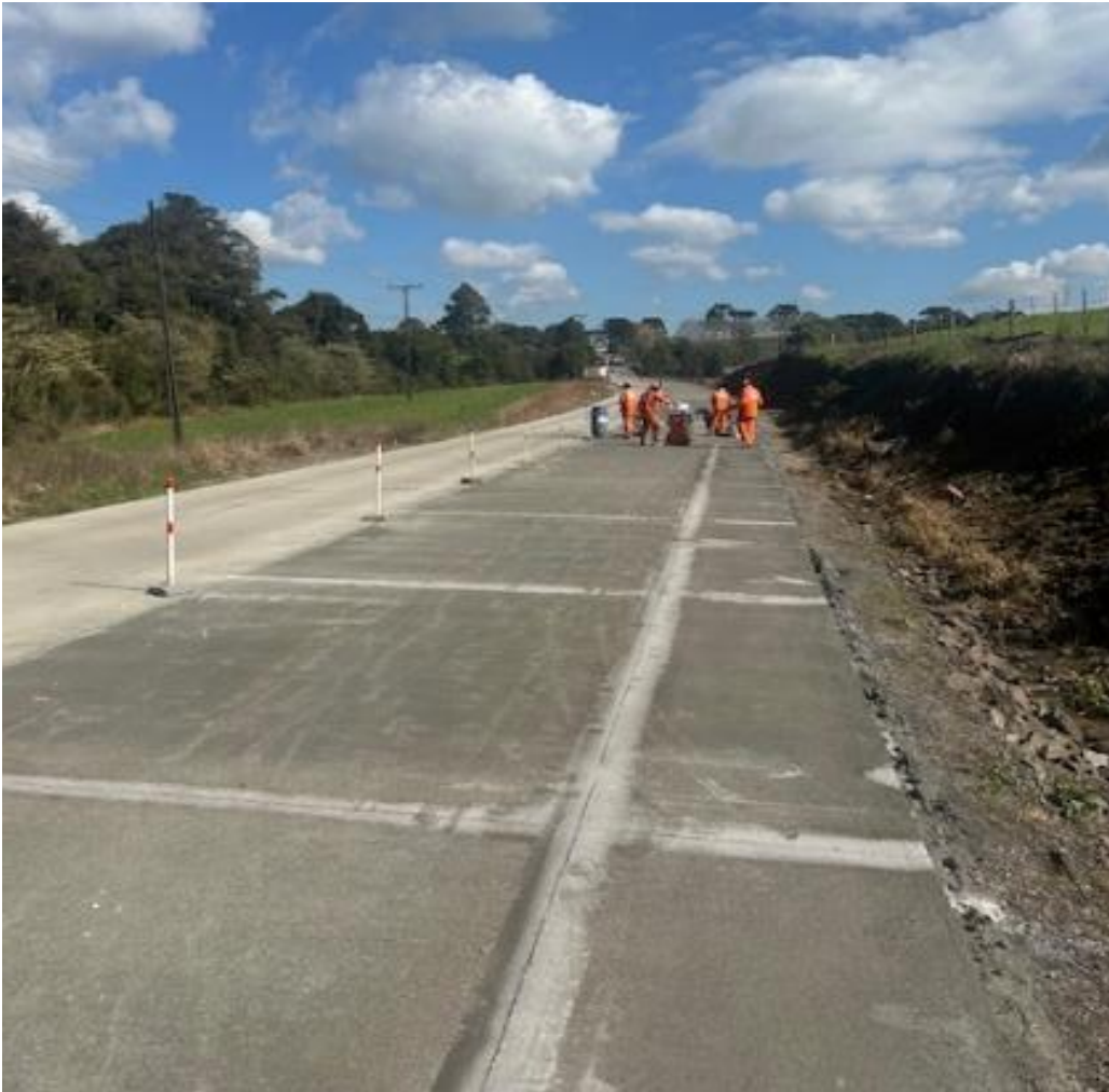
16 – Execução das juntas de dilatação no km 26,00
