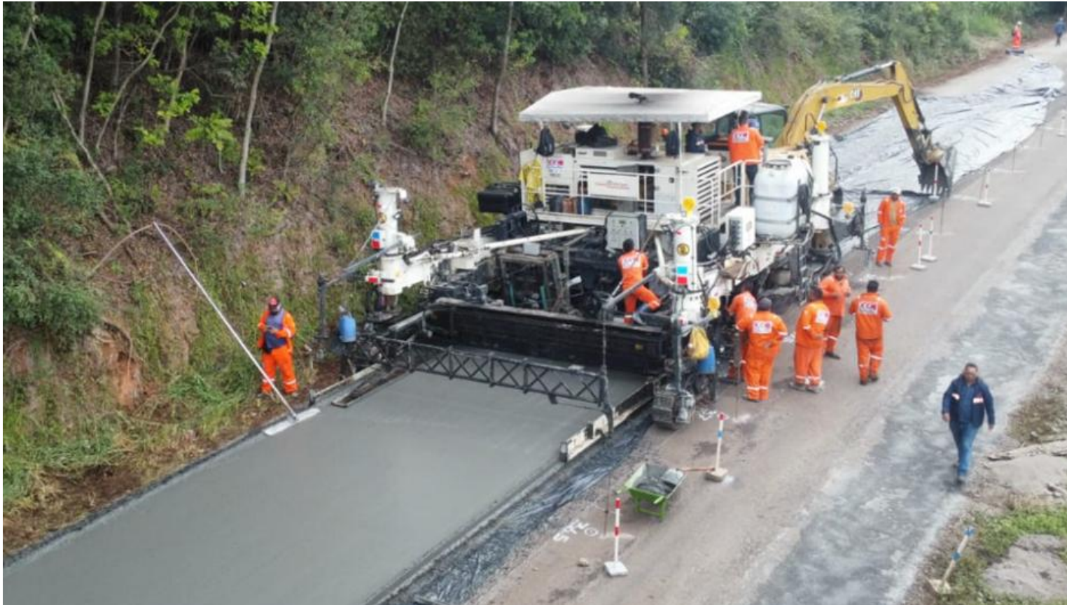
10 – Execução do pavimento em concreto. (Foto divulgação)
