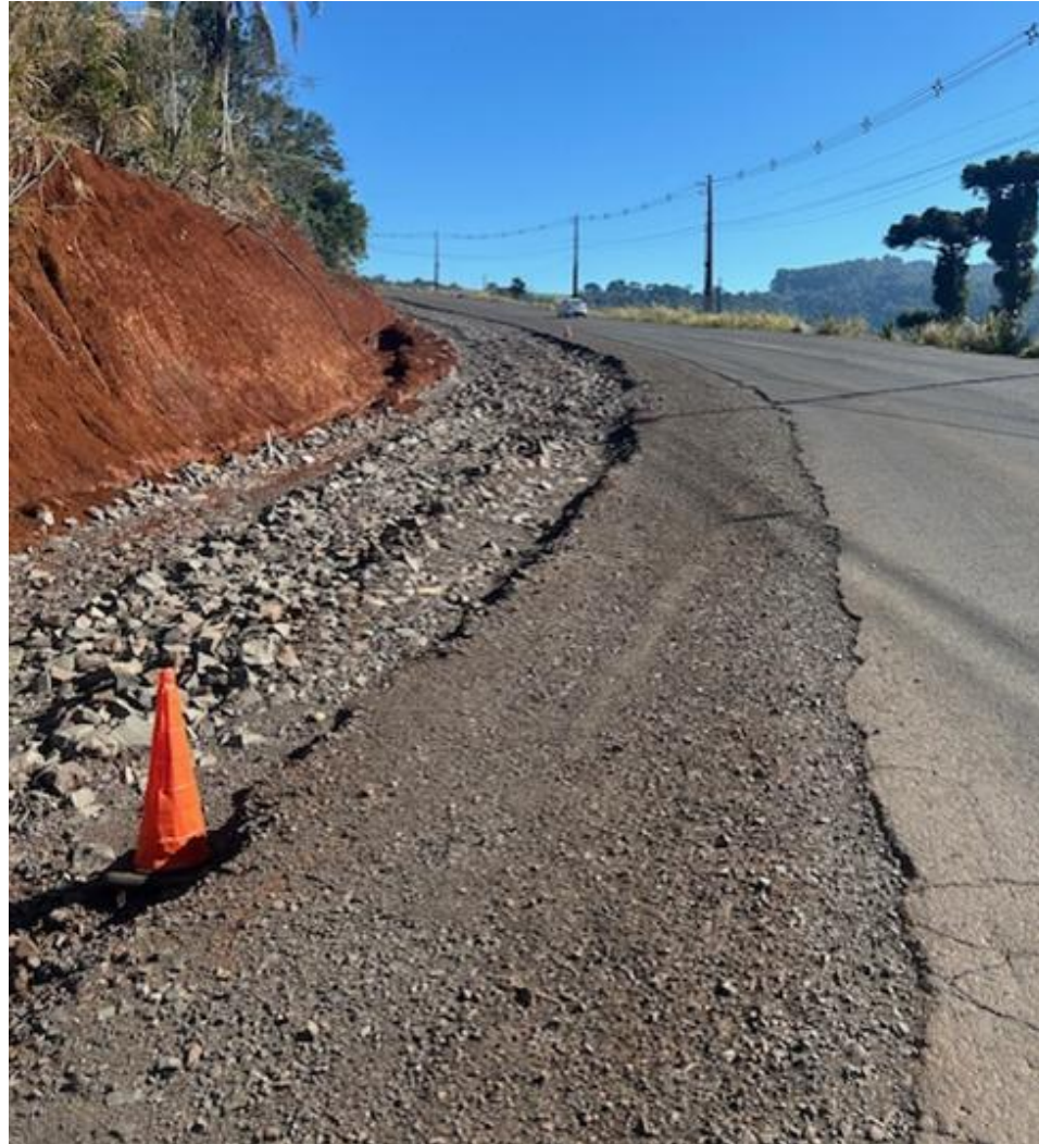
30 - Obras no km 52,00
