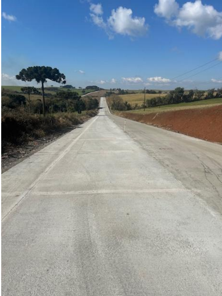
14 – Vista parcial da pista no km 24,10
