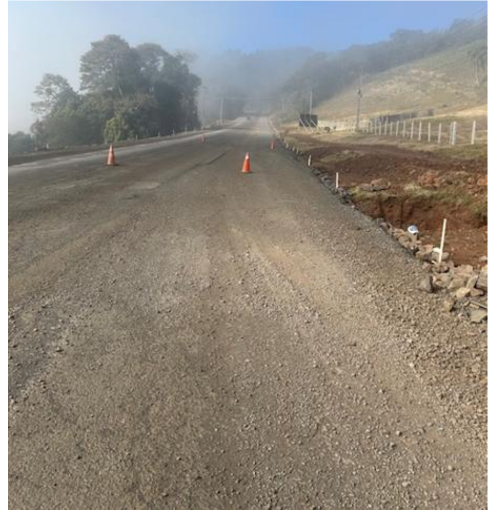
29 - Execução do pavimento para 3ª faixa no km 58,00
