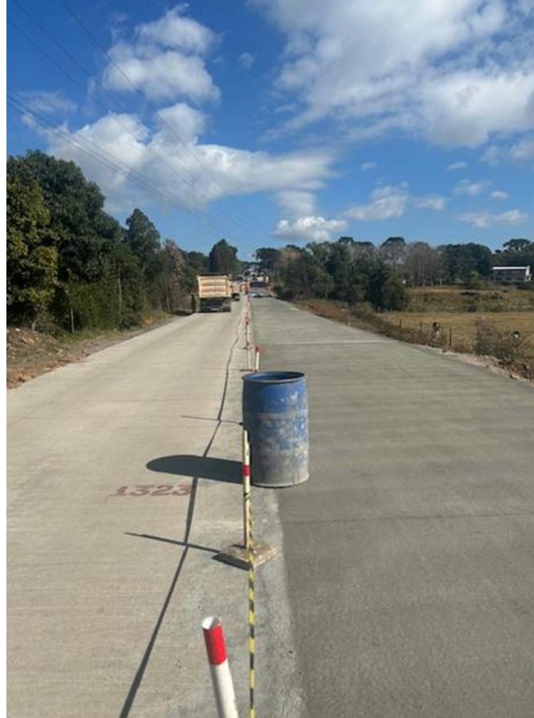
15 – Pista em concretagem no km 26,50
