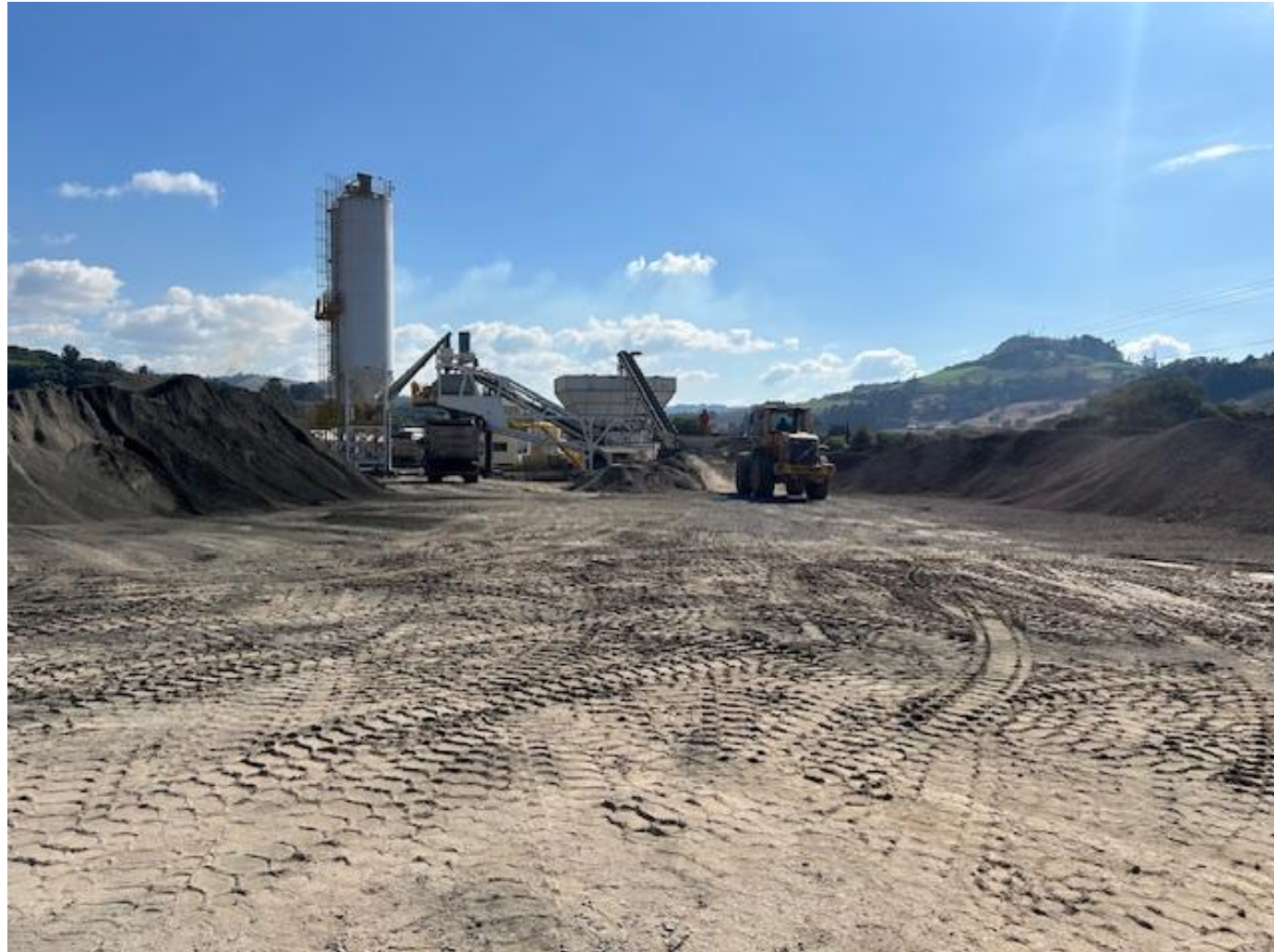
11 – Usina de concreto – km 16,00
